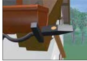
Passenden PREFA-Rinnenendboden aufstecken und mit Kunststoffhammer und Schaleisen zubördeln
