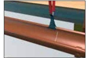
Hinteren Rinnenbug schließen; bei fachgerechter Klebeverbindung muss der Kleber an der Innenseite austreten
