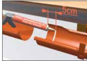
Mit PREFA Spezialkleber eine Kleberaube mit ca. 8 mm Dicke aufbringen
