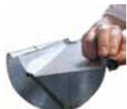
Legen Sie die Teilstücke nun mit einer Überlappung von 25 mm aneinander. Befestigen Sie den Dachrinnenschutz alle 50 cm mit einer Klammer an der Vorderseite der Dachrinne. Abschließend die Teilstücke zusammenschrauben.
