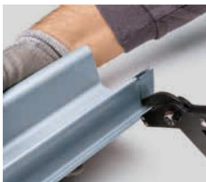
... und z. B. mit einer Blechschere oder einem Blechknabberer ausgeschnitten.
