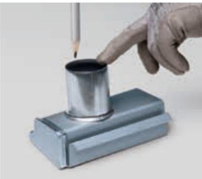
Der Rinnenstutzen wird angezeichnet (Durchmesser max. 60 mm).
