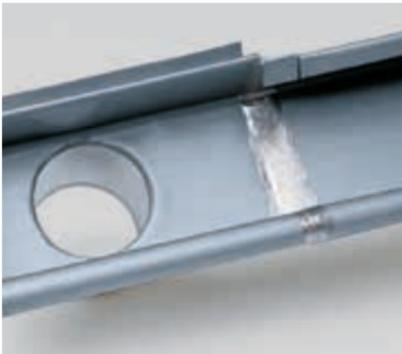
... und nach dem Löten wird der Kastenrinnenwinkel zusätzlich mit dem überstehenden Blechteil (Ausklinkung der Rinne) fixiert.
