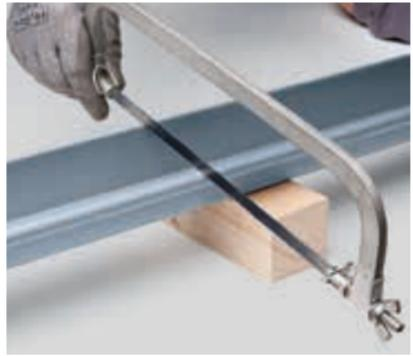
In der Regel wird zum Ablängen der Rinne eine Eisen-säge verwendet.
