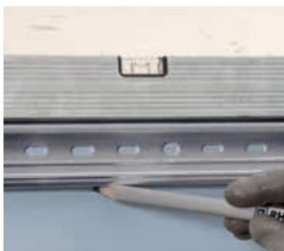
Die Rinnenschiene kann mit Neigung in Richtung Ablauf angebracht werden.
