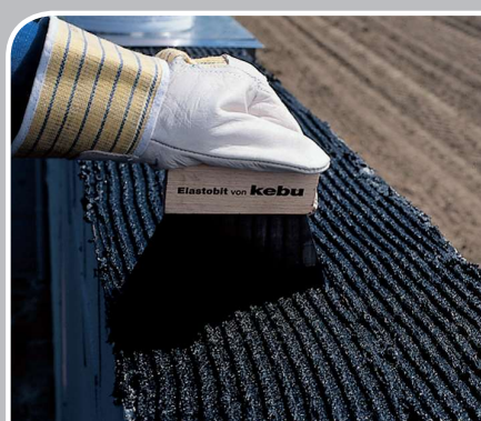
Der Auftrag von Orig. kebu Elastobit® erfolgt mit einem Rillenspachtel. Die Rillen müssen in einer Richtung verlaufen. Damit wird ein gleichmäßiger Auftrag erreicht.
